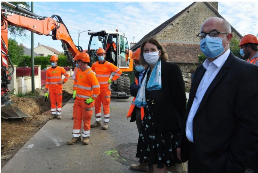
Régis Binet, président de la Fédération des Travaux Publics en Normandie, a expliqué la situation à la préfète de l'Orne Françoise Tahéri lors d'une visite de chantier à Forges. (©L'Orne Hebdo)
